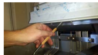
Billede 2 Brug en stang med lille diameter (1/8" maks.), eller en stjerneskruetrækker til at nå igennem adgangshullet og tryk på nulstillingsknappen.
